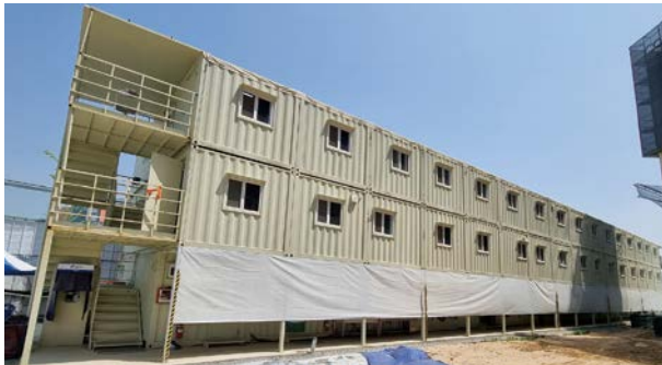
〈대우건설〉 음성푸르지오 현장사무실
