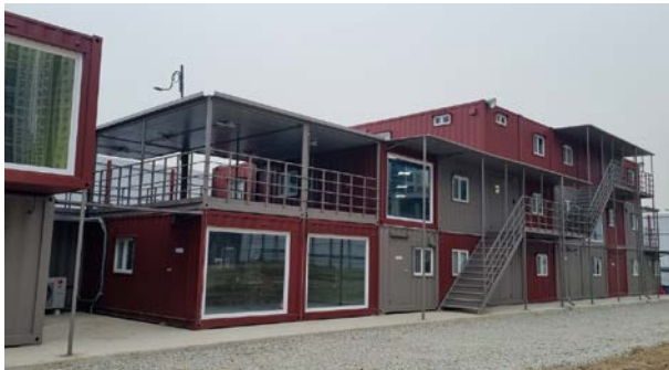
〈태영건설〉 의왕오전나구역 현장
