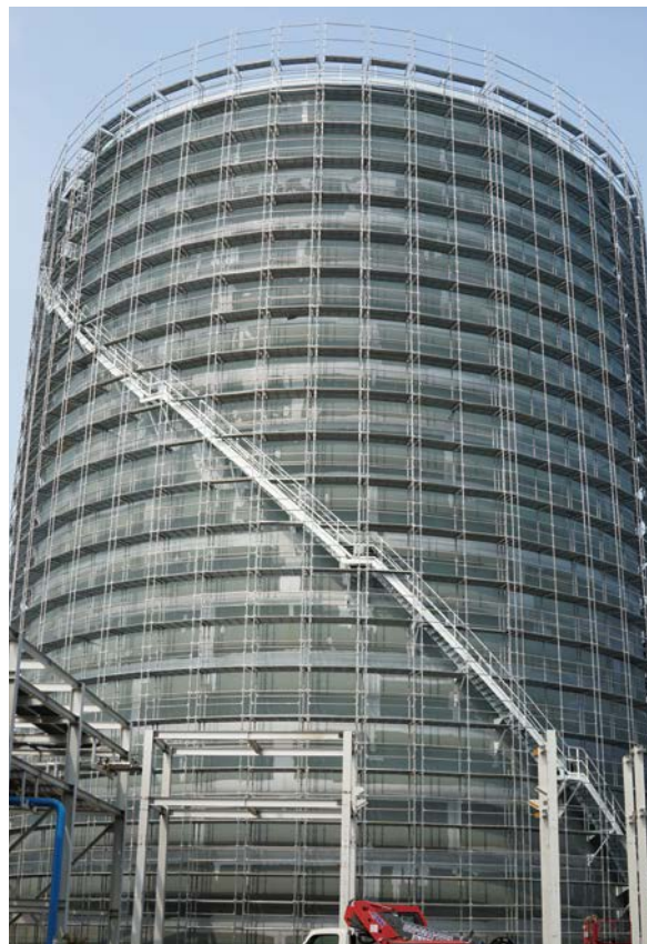
평택에너지서비스(주) 오성복합화력발전소 축열조 보수공사
