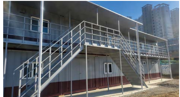
〈대보건설〉 경기광주 운동장 건립 공사 현장
